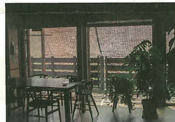
窓の屋外側で日射遮へいし、通風を行っている部屋。夏に涼しい室内空間をつくるためには、窓の屋外側で日射を遮り、壁からの放射温度が30℃を超えないようにすることが大切だと宿谷氏は言う
